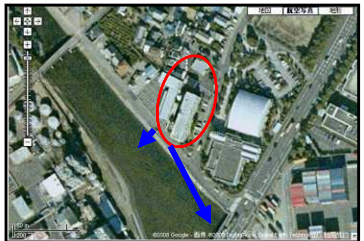
写真 3－5 6 市営清水横砂団地航空写真
