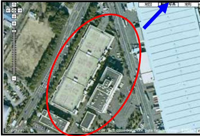
写真 3－6 3 清水北部浄化センター
