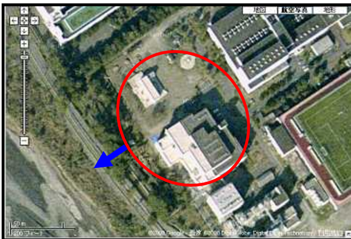
写真 3－7 5 中島浄化センター
