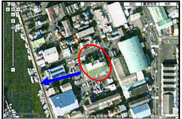
写真 3－26 清水築地ポンプ場航空写真
