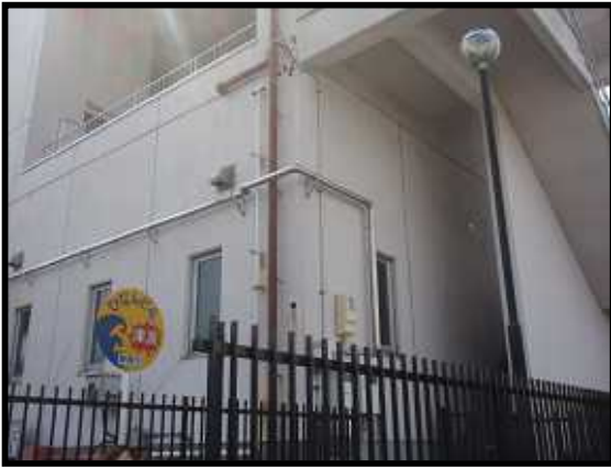
写真 3－25 清水築地ポンプ場
