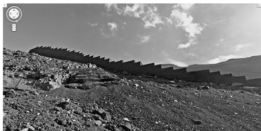
写真2—富士山吉田口登山道六合目付近の落石防護ブロックによる景観破壊 こうしたブロックや鉄柵は八合目付近まで多数設置されている。GoogleMap のストリートビューより。
