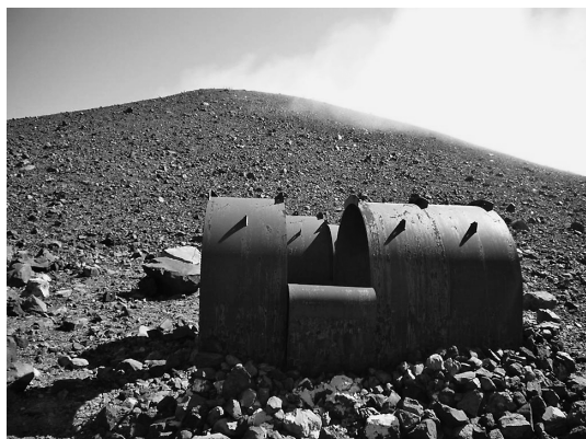
写真1—浅間山 2004 年噴火の大きな噴石(火山弾)によって屋根が陥没した鋼板製のシェルター(火口から約 500 m 地点) 早川由紀夫撮影
