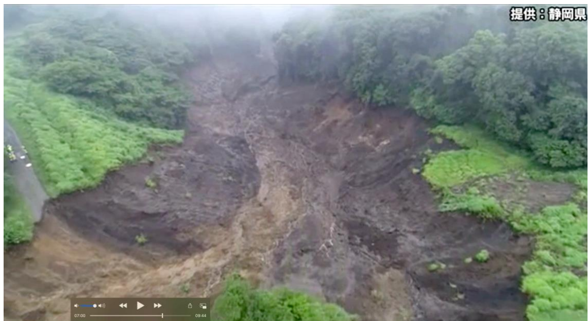
図7 静岡県による2021年7月4日撮影のドローン映像より
